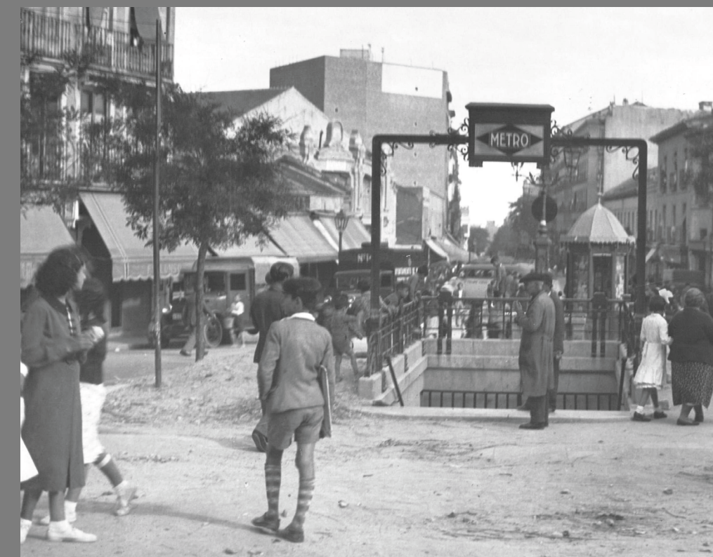
Boca de acceso de la estación de Lavapiés en la plaza del mismo nombre, 1936 [Archivo ABC]
