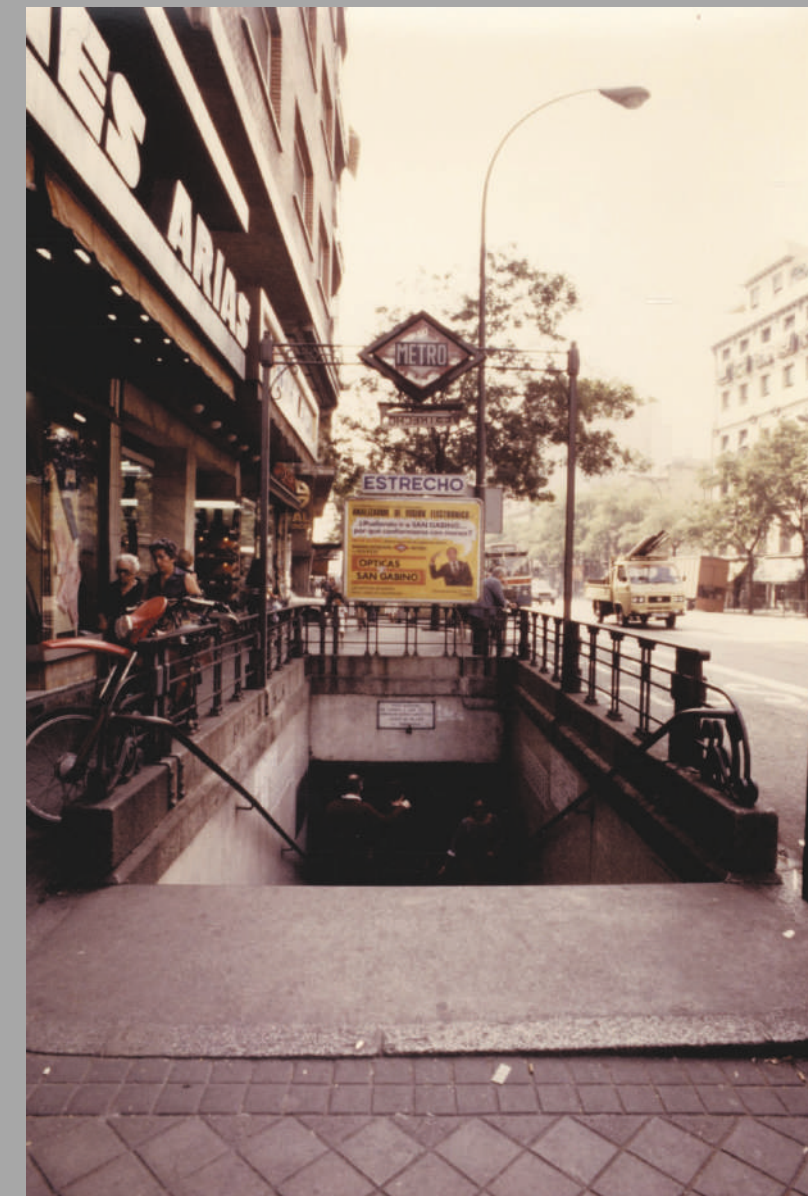
Boca de acceso de la estación de Estrecho, 1982 [Archivo Histórico de Metro de Madrid]
