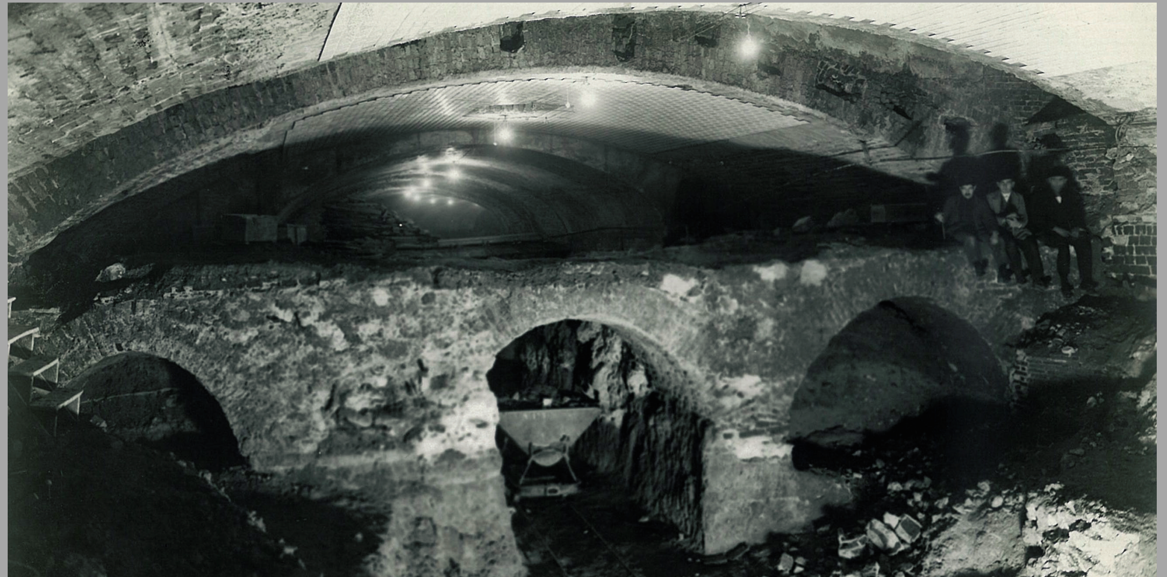
Obras de construcción. El acueducto de Amaniell atraviesa de lado a lado el andén, ca.1923 [Archivo Histórico de Metro de Madrid]
